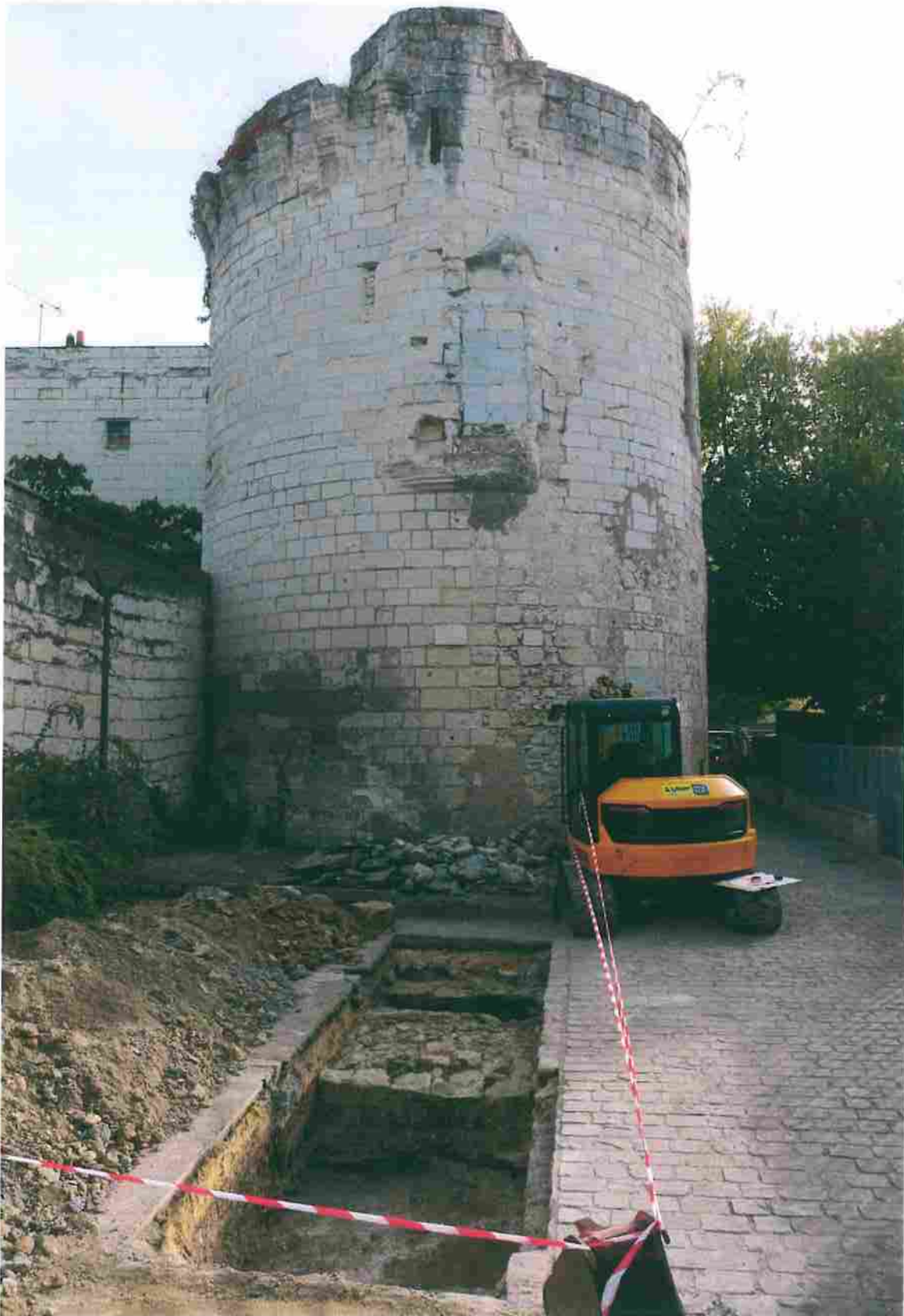
Fig. 8 : Vue de la tour du Bourg depuis le nord.
