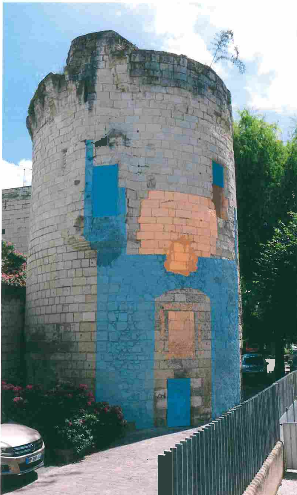
Fig. 22 : Vue de la tour du Bourg depuis le nord-ouest, avec restitution des dispositions originelles en bleu et indication des principales reprises en orange.
