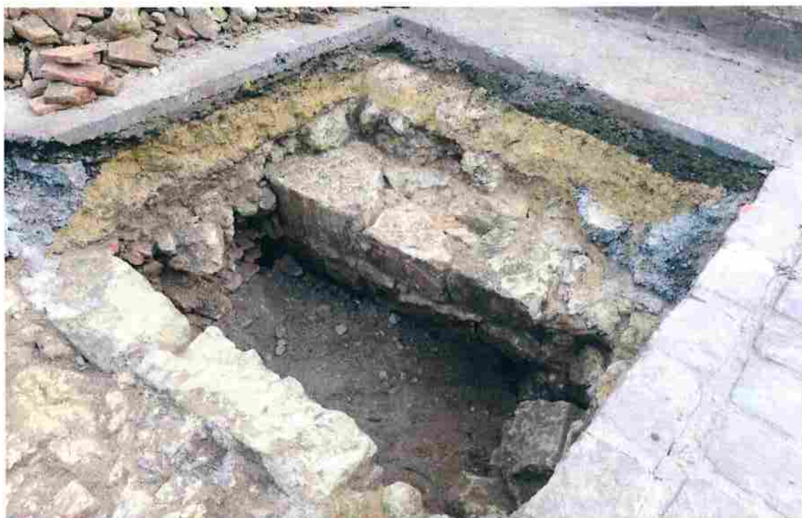
Fig. 18 : Vue de la fosse (UE 17 et 19) aménagée au sud de la courtine UE 14. Le comblement (UE 15) a laissé subsister de nombreuses poches de vide.
