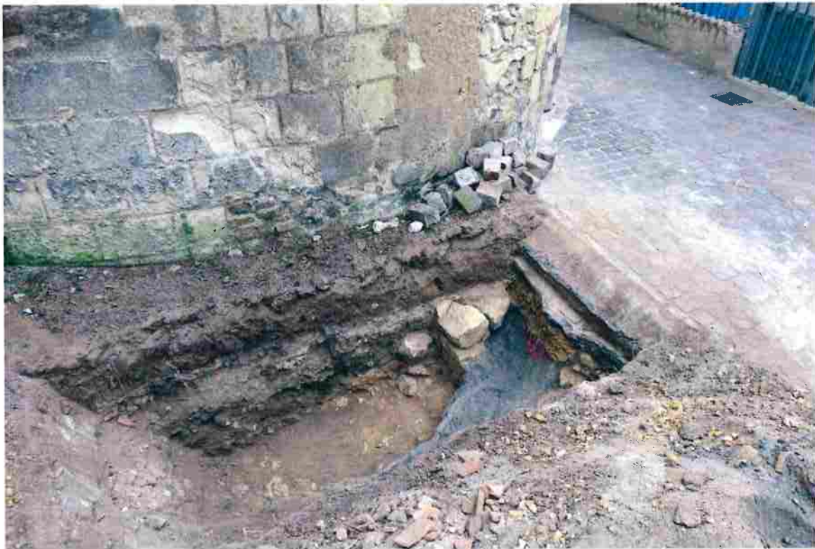
Fig. 12 : Vue du sondage 1 depuis le nord-est. La maçonnerie UE 8, recoupée par la tranchée liée à la mise en place d'un réseau électrique, se trouve à l'aplomb de l'arrachement de courtine visible sur l'élévation de la tour du Bourg.
