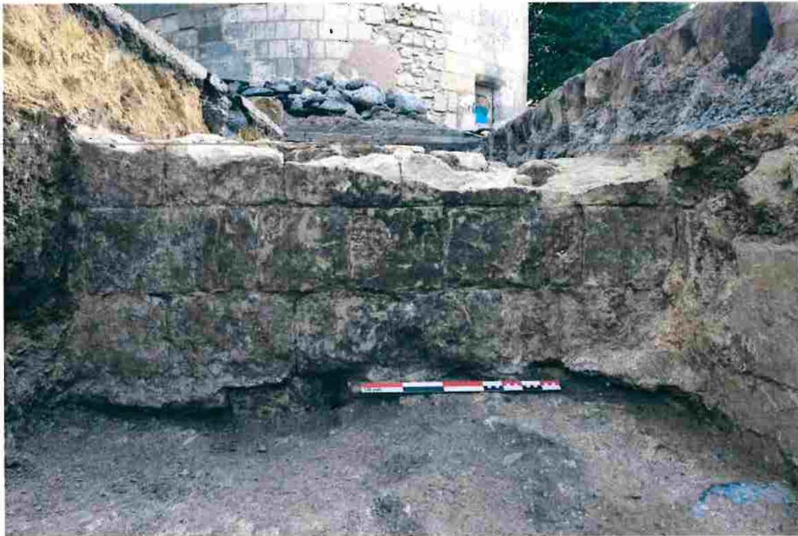
Fig. 15 : Vue du parement nord du pan de courtine UE 14, contre lequel a par la suite été aménagée une fosse d'extinction de chaux (UE 12), ce qui explique la présence de dépôts gris-blancs.
