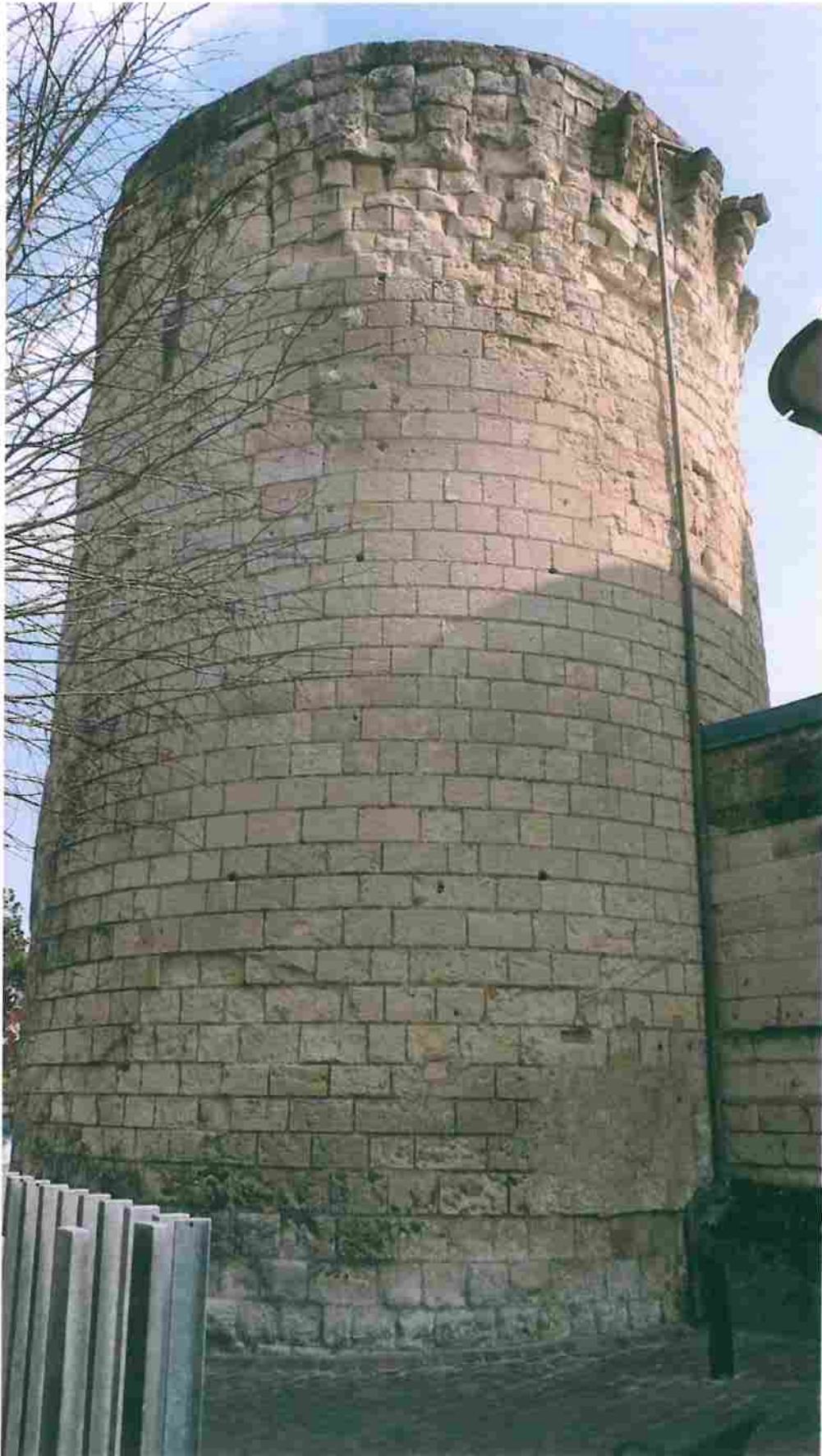
Fig. 19 : vue de la tour du Bourg depuis le sud-ouest.
